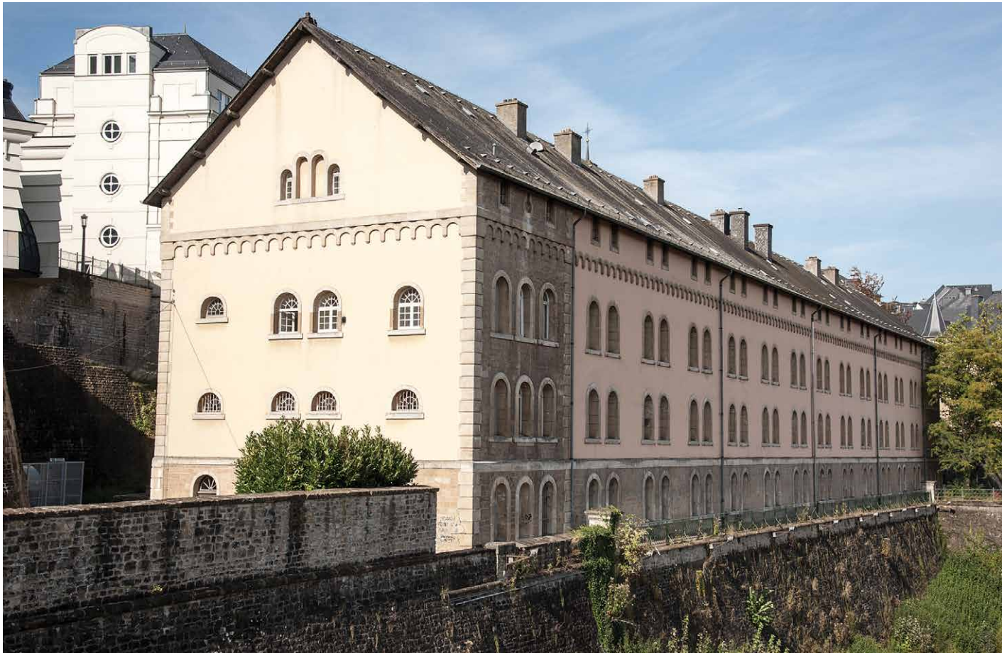
Bâtiment principal des Archives nationales – site du Plateau du Saint-Esprit
