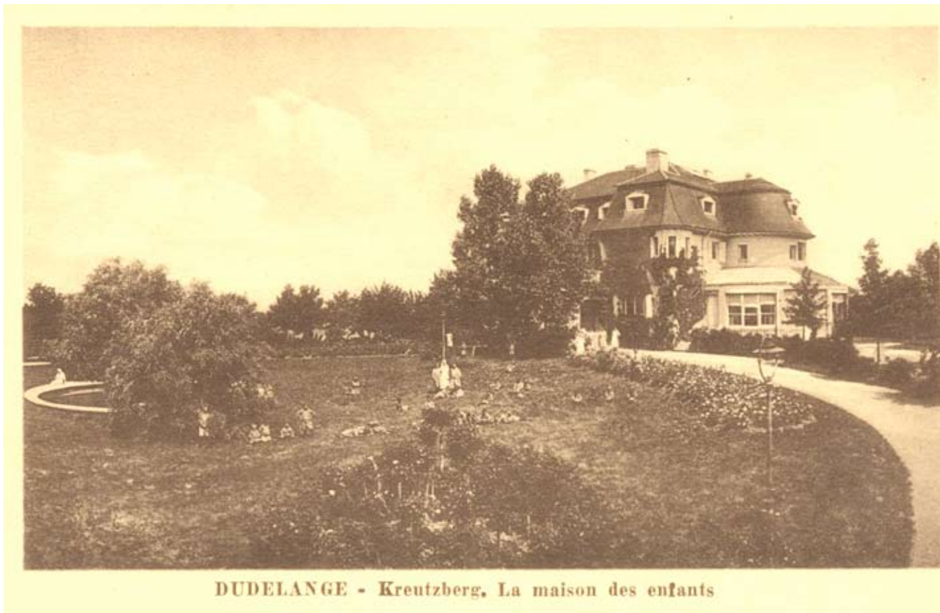
La maison Kreuzberg fut transformée en maison de soin pour enfants malades après le déménagement des Mayrisch.
