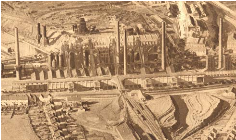
L'usine d'Esch (Terres Rouges).
