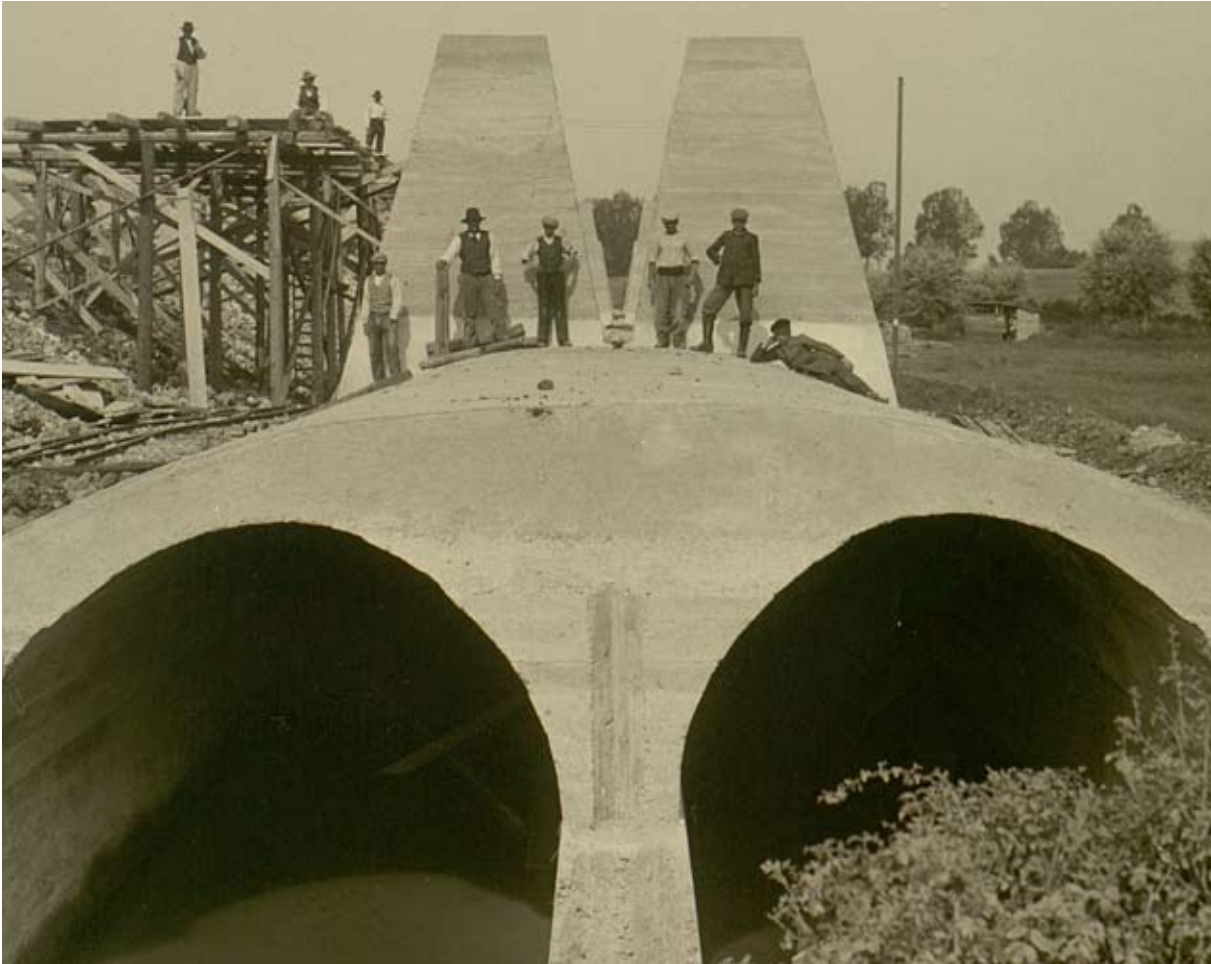
Le sous-sol marécageux du Escher Busch donna du fil à retordre aux ingénieurs allemands: pour assécher les fondations du complexe sidérurgique, ils durent aménager des centaines de mètres de chenaux en béton. Photo: Archives Nationales de Luxembourg
