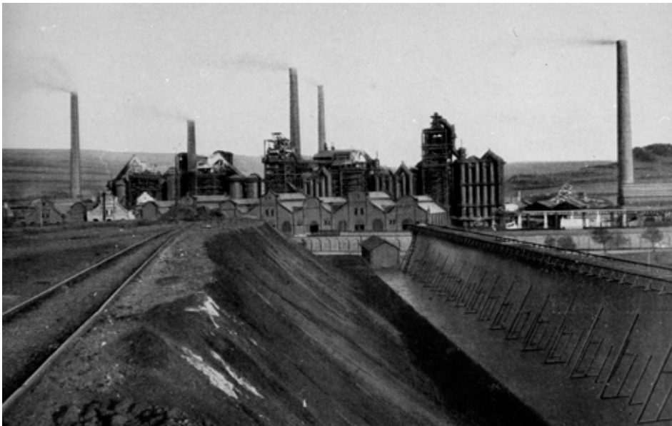
En 1905 (date de la photo) l'usine d'Esch-frontière dispose au total de cinq hauts-fourneaux, dont trois de 25 mètres et deux de 30 mètres de hauteur. La production journalière est respectivement de 200 et 250 tonnes de fonte.
